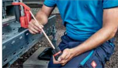
2. Escariar la parte externa del tubo
