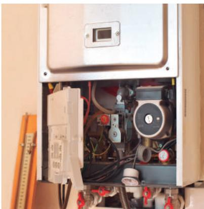
**Fig.35.** Ensamblaje de los componentes de la válvula de gas.
